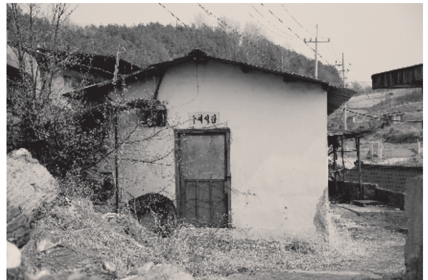
▲ 사용하지 않는 성광성냥 구내식당 건물. 한때 60명이 일할 정도로 호황을 이루었을 때 지은 식당이다. 지금의 텅 빈 모습이 보는 이로 하여금 쓸쓸함을 느끼게 한다.
